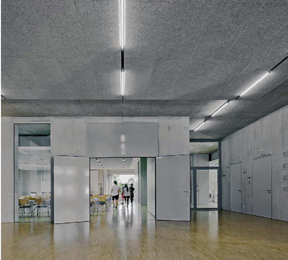
Decken und massive Wände sind in Sichtbeton ausgeführt, akustisch aktivierte Deckenflächen mit Holzwolle-Leichtbauplatten.
