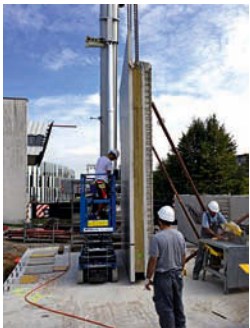
Montage eines Beton-Sandwich-Elementes an der Baustelle
